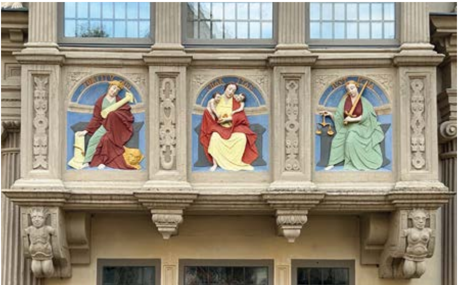
Hexenbürgermeisterhaus · Detailbild des Erkers
